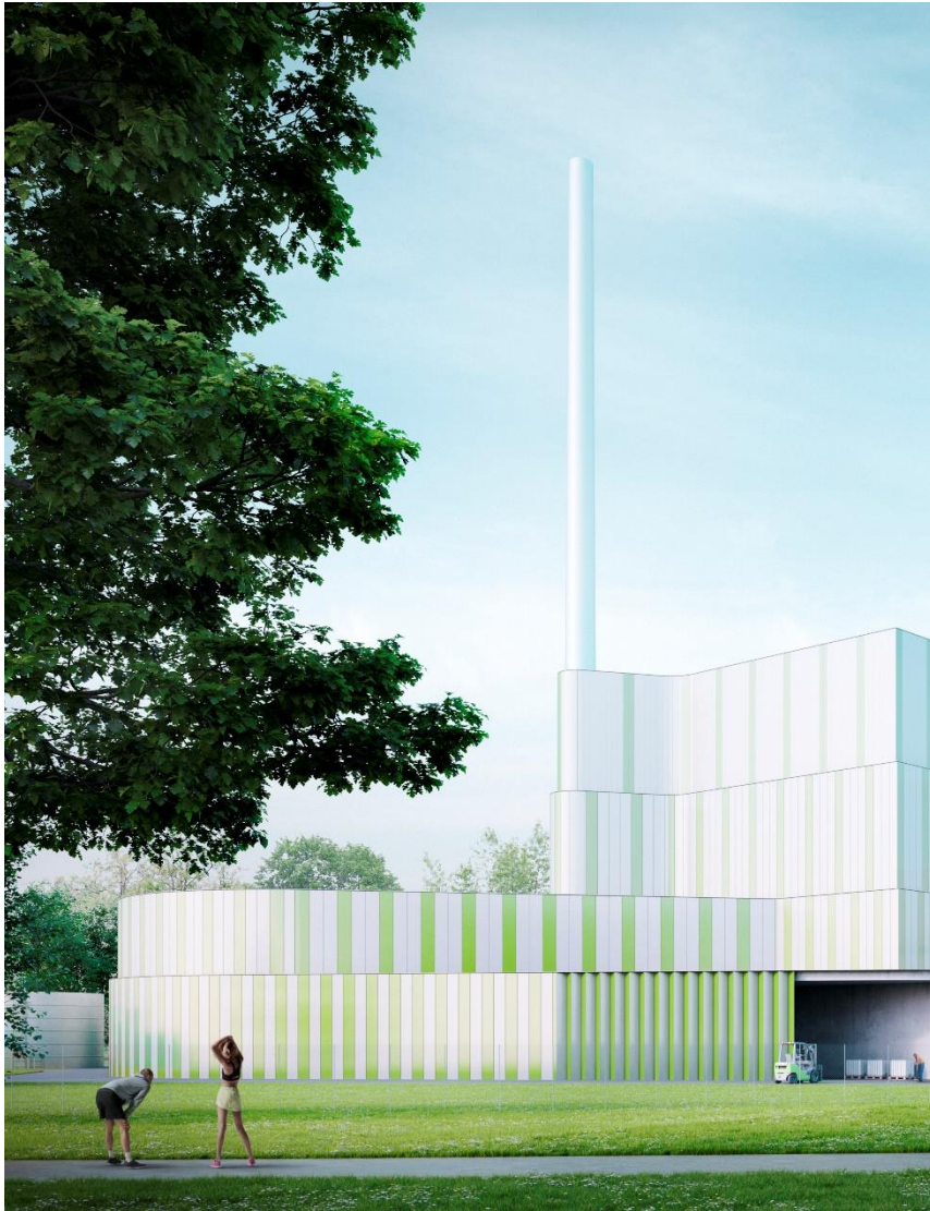
Il nuovo camino di colore grigio-azzurro atmosferico è fondato sulla copertura del volume principale. Tale collocazione ne riduce ulteriormente la percezione dell'altezza.
