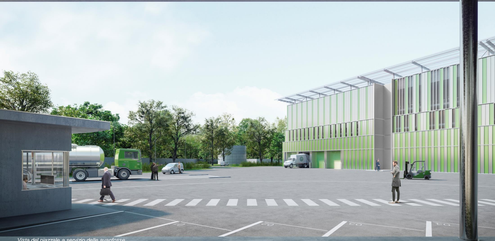
Vista del piazzale a servizio delle avanfosse e della sala controllo dal porticato di ingresso
